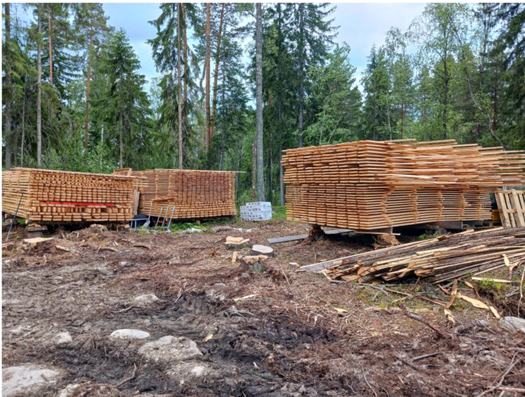
Kuva 6. Rakennusalueen puista kenttäsiirkelillä sahattu puutavara kuivumassa "taapeleissa".
